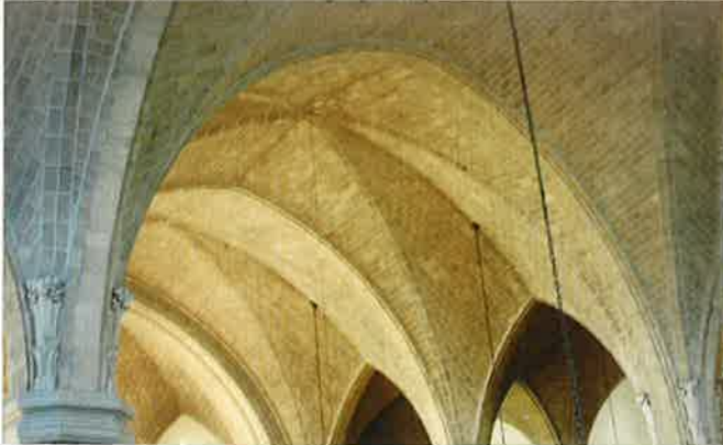
Vue d'une section des voûtes du plafond de l'église (photo G.L.)
