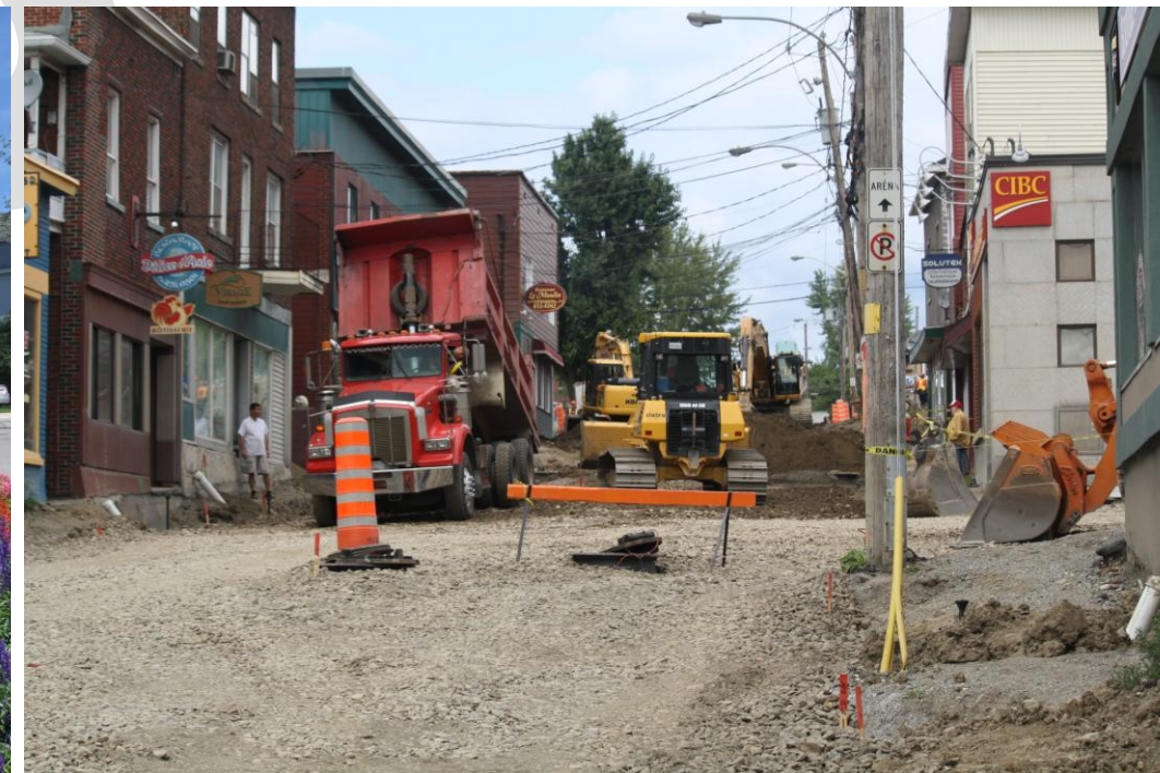
Travaux sur la rue Angus Nord
