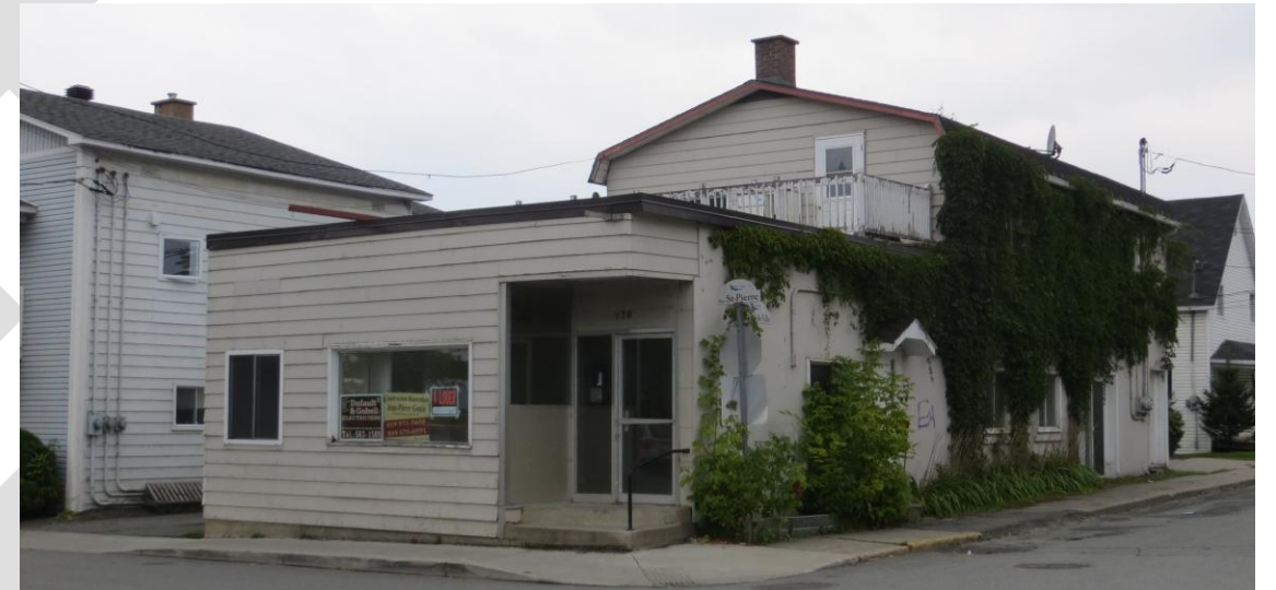
Bâtiment au 178, rue Saint-Pierre – Avant rénovation
