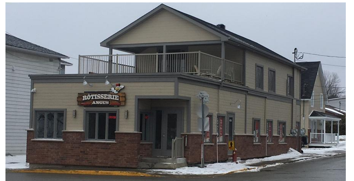
Bâtiment au 178, rue Saint-Pierre – Après rénovation
