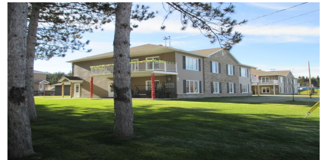
Place du Havre, rue Warner
