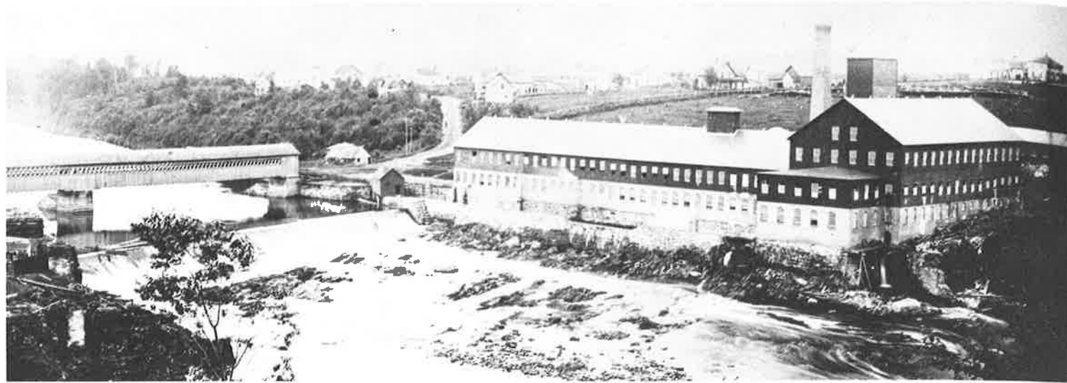
Ancien pont de bois - Usine
