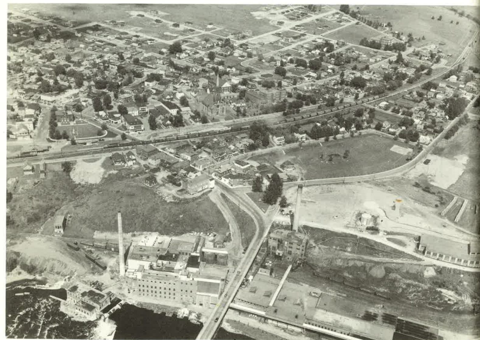
L'ENSEMBLE DES MOULINS DE LA DOMTAR
