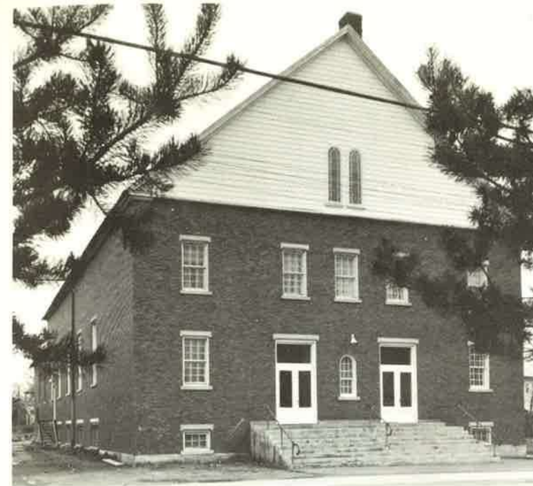
Salle Paroissiale - Plamondon Ancienne église
