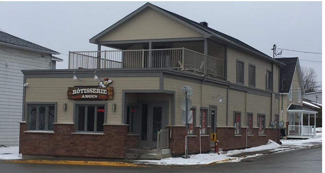
Bâtiment au 178, rue Saint-Pierre – Après rénovation
