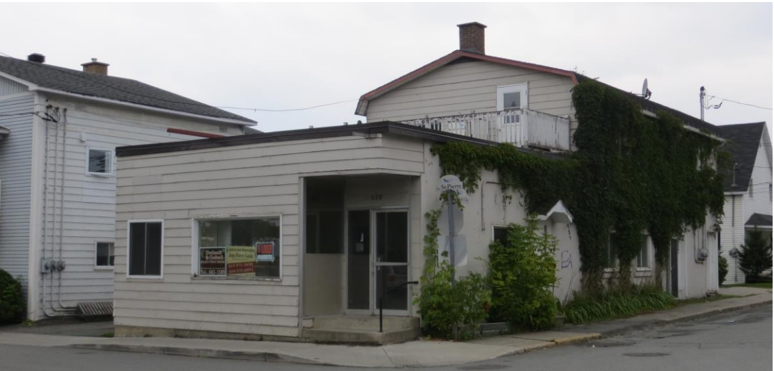
Bâtiment au 178, rue Saint-Pierre – Avant rénovation
