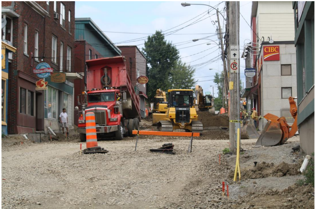
Travaux sur la rue Angus Nord
