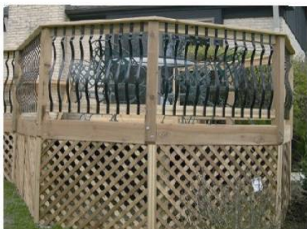
LES TERRASSES AMÉNAGÉES EN PORTE-À-FAUX DOIVENT FAIRE L'OBJET D'UN TRAITEMENT ARCHITECTURAL POUR MASQUER LE VIDE.
